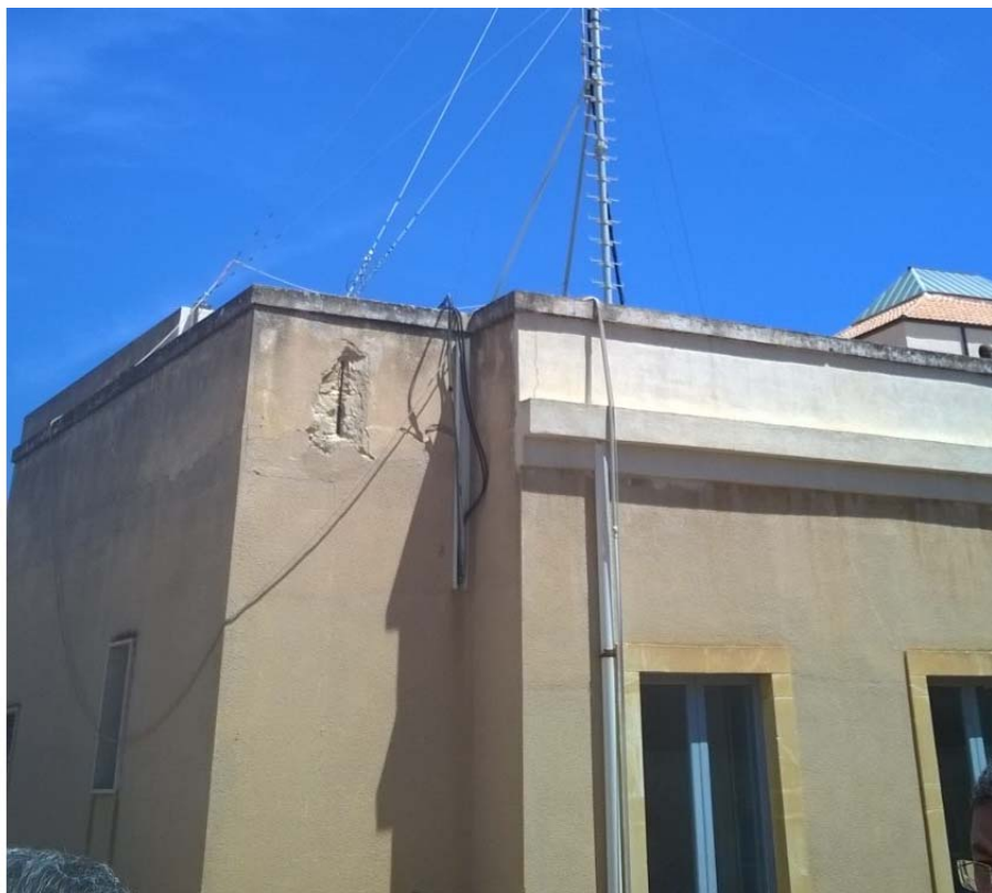
Figura 11 – Distacco calcinacci
