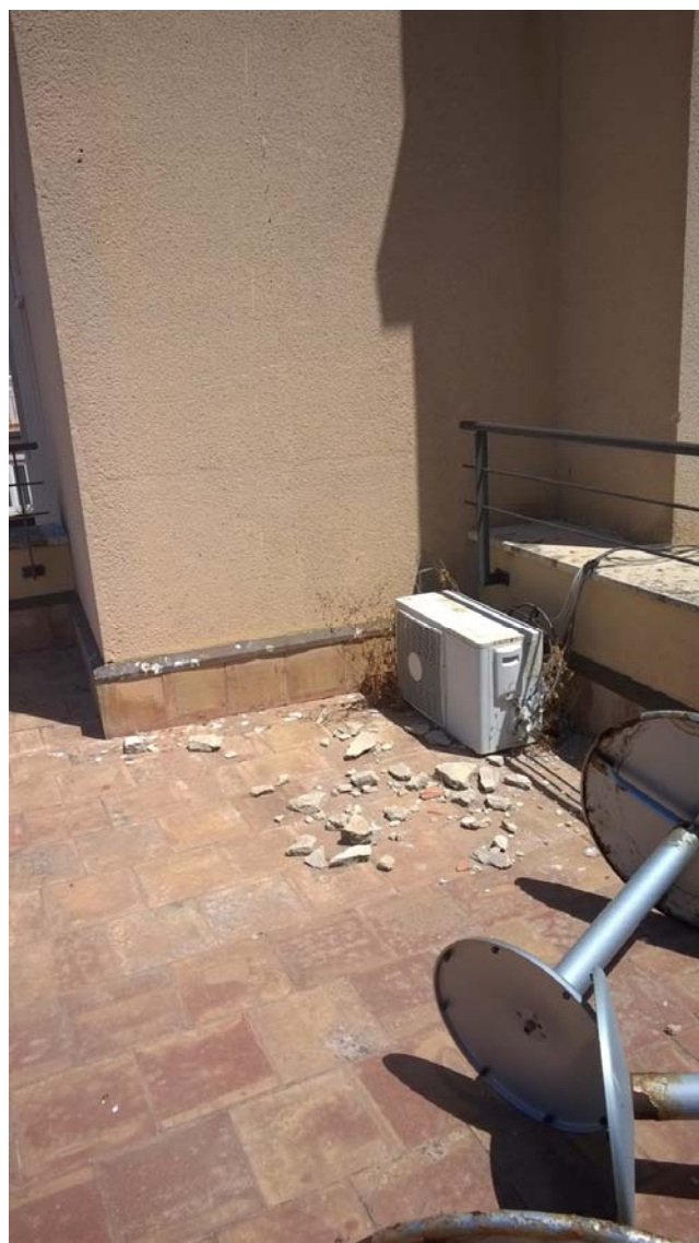
Figura 09– distacco intonaci
